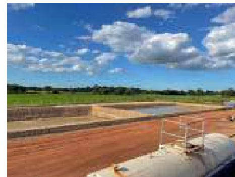
รูปที่ 3-5 ตัวอย่างป้อที่ใช้พักเศษดินเศษหินจากการเจาะช่วงบน (Top hole cutting pit)
