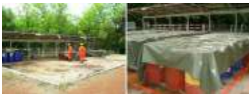
รูปที่ 3-6 ลักษณะพื้นที่จัดเก็บกากตะกอนปนเปื้อนน้ำมันจากการทำความสะอาดท่อขนส่งน้ำมัน ภายในสถานีผลิตลานกระบือ
